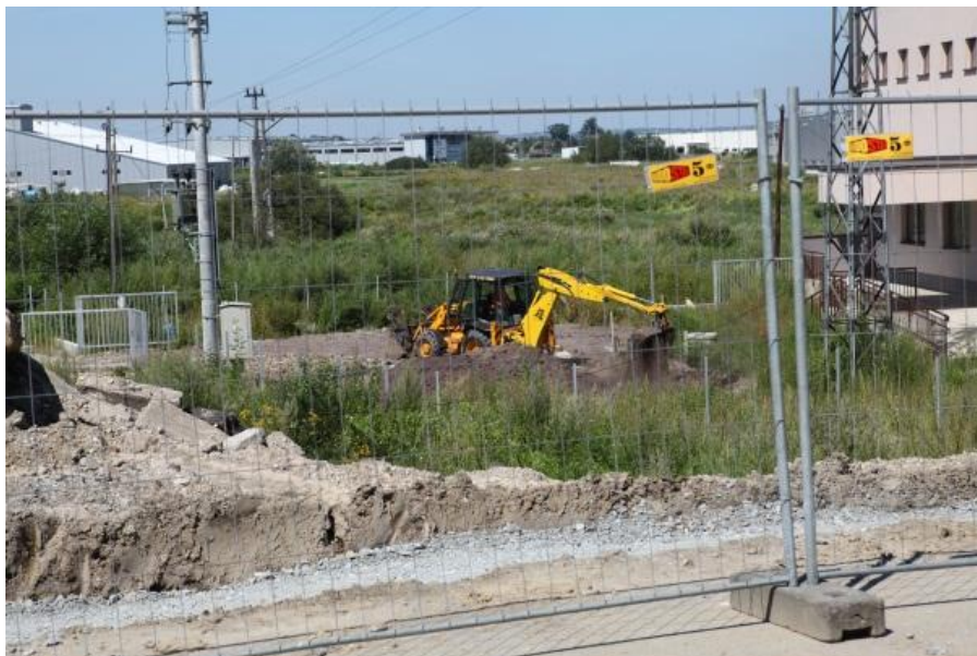
Fot 5 Optymalizacja wielkości wykorzystywanych maszyn budowlanych w zależności od ukształtowania terenu oraz dostępności obszarów operacyjnych.
