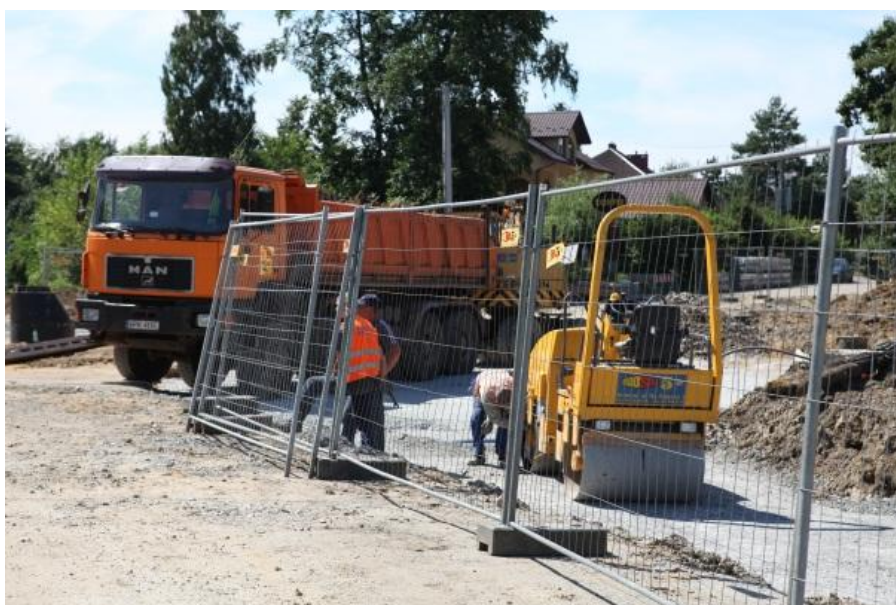
Fot 3 Naprawy maszyn budowlanych przeprowadzana przy wyłączonych silnikach spalinowych.
