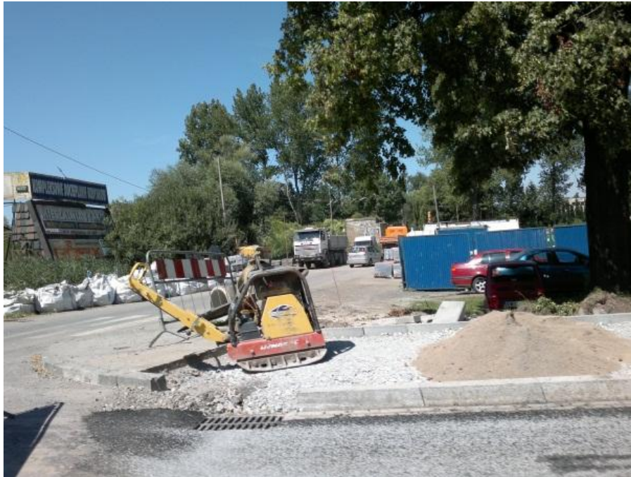
ot 1 Rozmieszczenie maszyn budowlanych pozwalające na ich szybkie wykorzystanie – pozostawiane na czas przerw w pracy z wyłączonym silnikiem.
